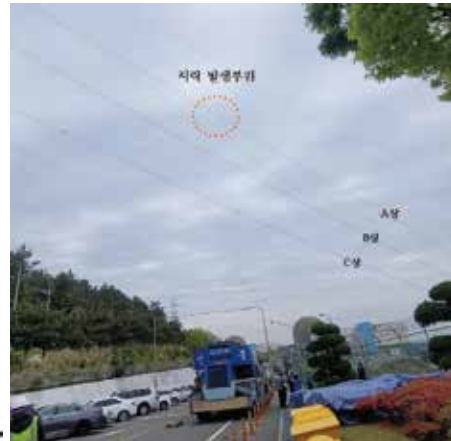
* 사고발생 송전선로 및 크레인 현장사진
