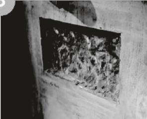
**4** Back-up Bar 설치, 충전재 양생 완료
