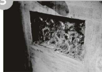
4 Back-up Bar 설치, 충전제 양생 완료
